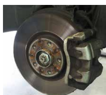
錆び止め塗布前
